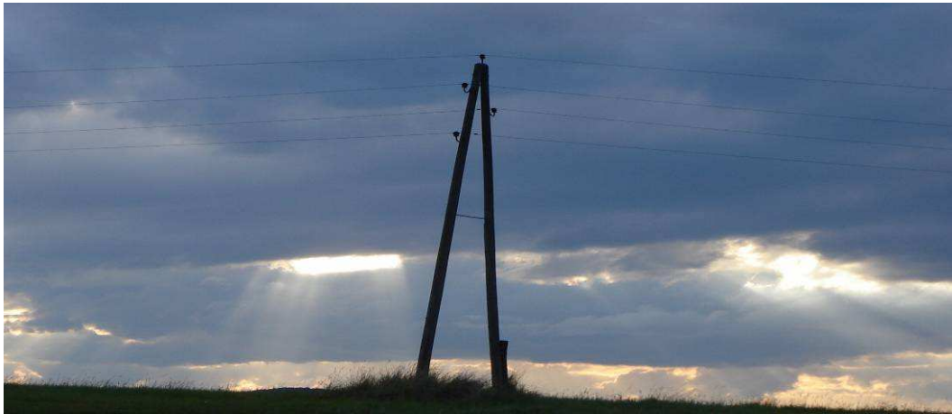
Slika 8.1: 10 kV “A” stub sa zaštitnim užetom (zaštitno uže se vrlo retko postavlja na stubove 10 kV mreže, jer je njegova efikasnost mala zbog malog rastojanja u odnosu na fazne provodnike)
