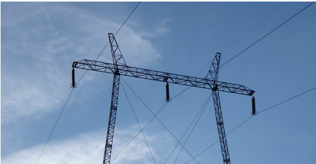
Slika 6.2: Noseći 220 kV portalni stub
