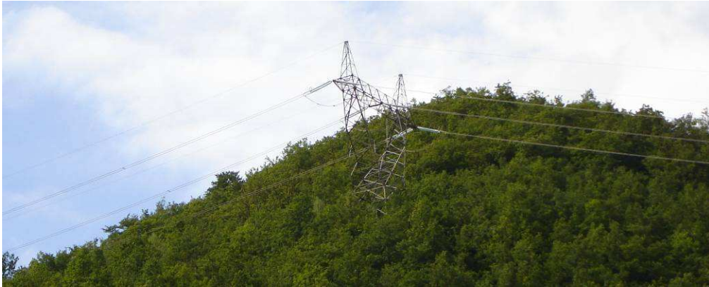
Slika 6.1: Zatezni 400 kV “Y” stub
