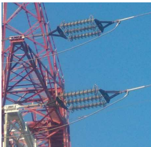
Slika 4.1 Trostruki izolatorski lanci na jednom zateznom stubu 110kV voda
